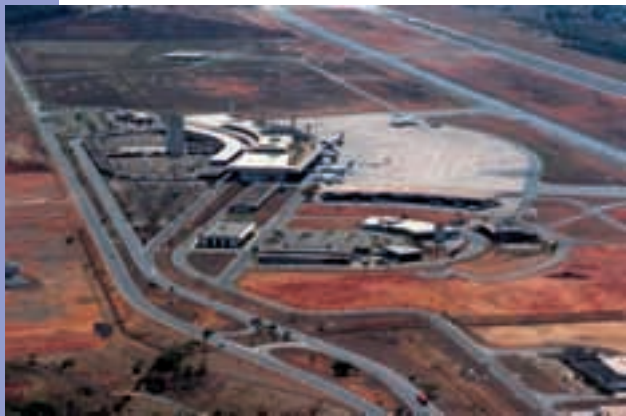
Aeroporto Internacional Tancredo Neves, durante as obras
