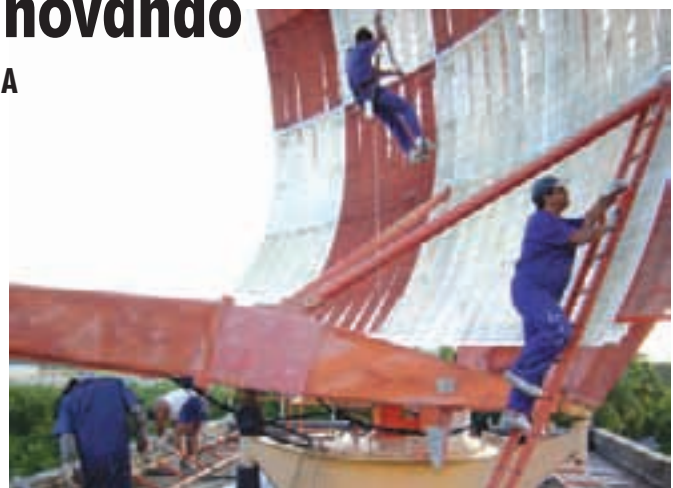
Manutenção do radar LP23M e escapamento de GRUGER da KF do DTCEA-SV
